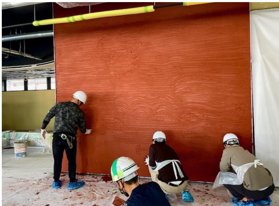
7F リフレッシュルームの作業風景。指引きすることで壁に表情が出ます
